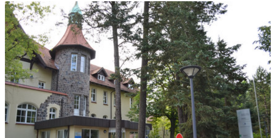
Institut für Ernährungswissenschaft (Rehbrücke)
